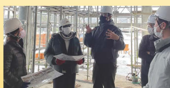
県立美術館建設現場を視察
